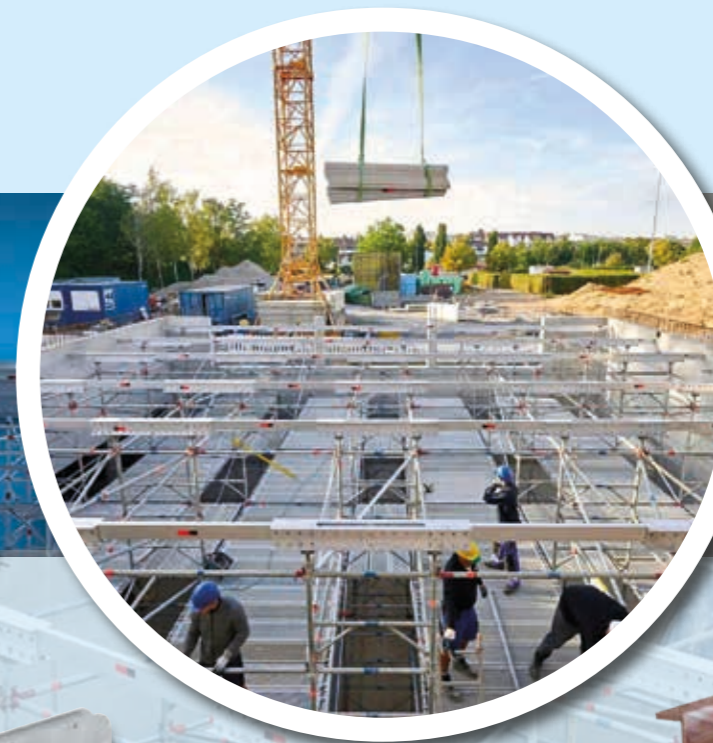
TwixBeam onderslag met 35 cm H20 dragers compact.
